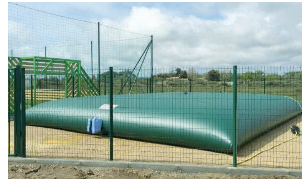
Réserve incendie en citerne souple Photographie d'illustration
